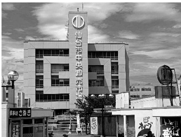
中央卸売市場本場（管理棟）
