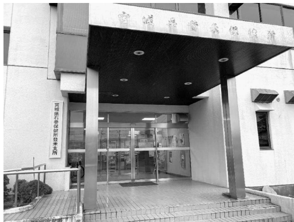
宮城県登米保健所の文字が削られ、横に宮城県石巻保健所登米支所の看板を設置
