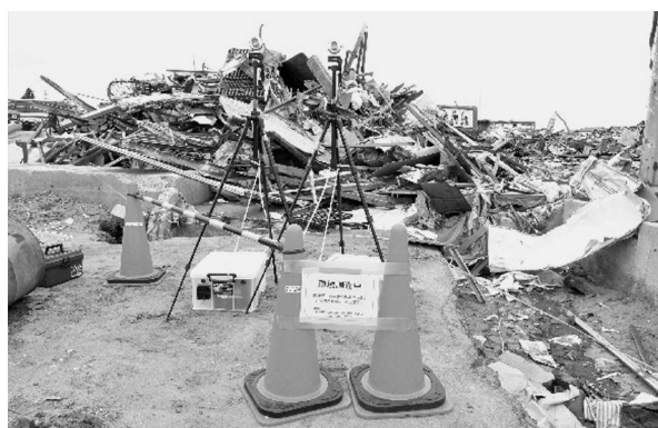
写真6 がれきの撤去現場
