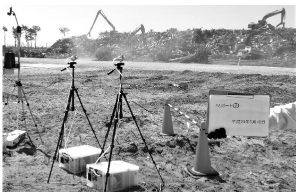
写真4 荒浜搬入場での測定の様子
