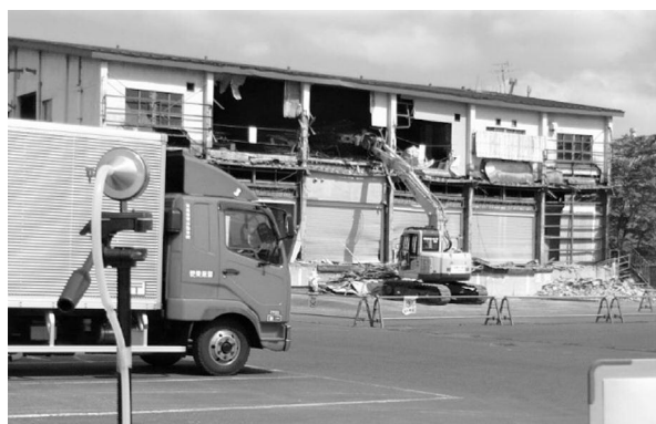
写真7 解体現場の様子
