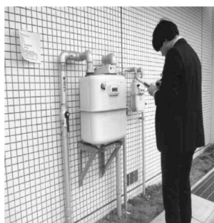
建物被害状況・ライフライン確認中
